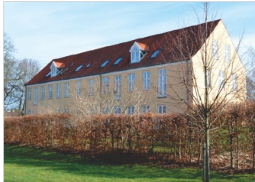
Det tidligere rådhus ved Brønsholmsdal. De i teksten nævnte tilbygninger blev nedrevet efter flytning til det nuværende Rådhus.
